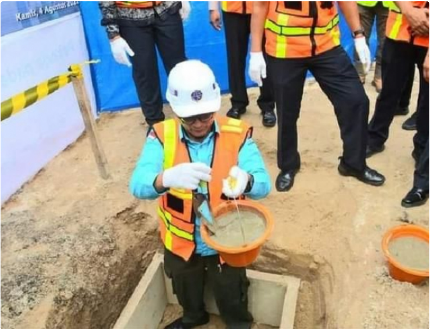
Pembangunan Shelter Kereta Api
